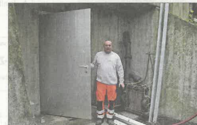
Von aussen sieht das Wasserreservoir Kohlplatz wie ein Bunker aus.
